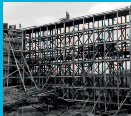
Bygging av dam
